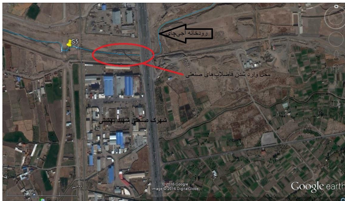
شکل ۴-۲ - نمایی از تخلیه فاضلاب صنعتی به رودخانه آجی چای قبل از ایستگاه S5
