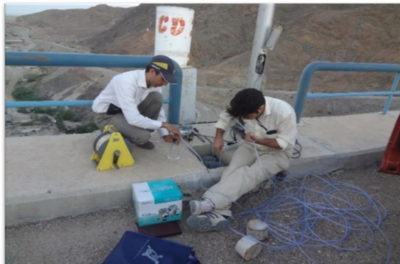
شکل ۳-۳ نمونه برداری از پیزومتر کاساگراند واقع در تاج سد با استفاده از پمپ مکش
