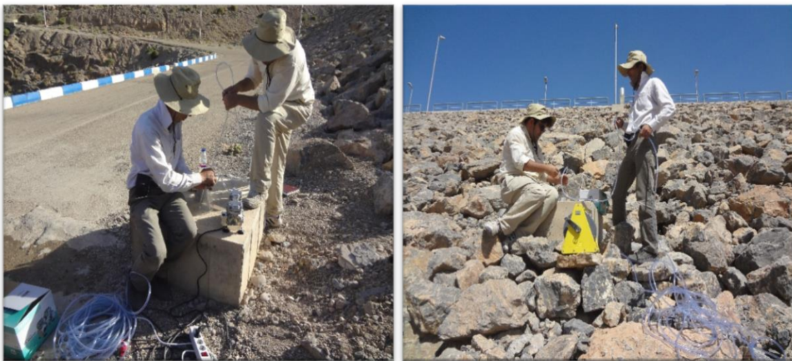
شکل ۳-۴ نمونه برداری از پیرومتر کاساگراند واقع در بدنه و پی سد با استفاده از پمپ مکش
