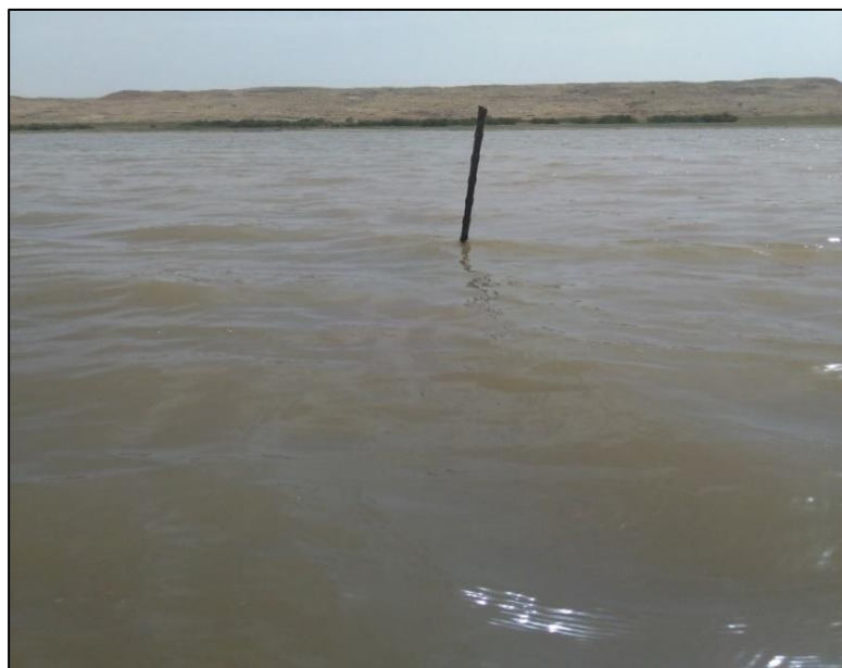
شکل ۳-۷- اشل نصب شده در سطح آب تالاب (دید به سمت جنوب غربی)
