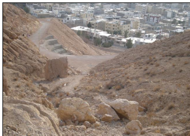
شکل ۳-۵: واریزهای موجود بر روی دامنه مشرف بر مناطق مسکونی
