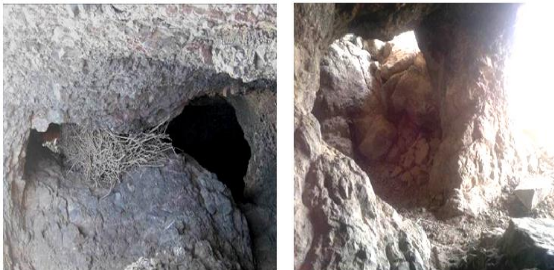
شکل ۱-۵) تصاویری از تونل‌های دنباله‌رو که در گذشته به منظور استخراج مس حفر شده است.
