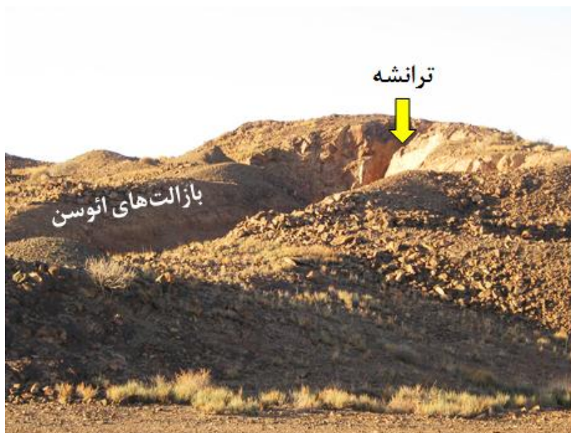
شکل ۳-۸) نمایی از ترانشه ایجاد شده در منطقه چغندر سر مرکزی.
