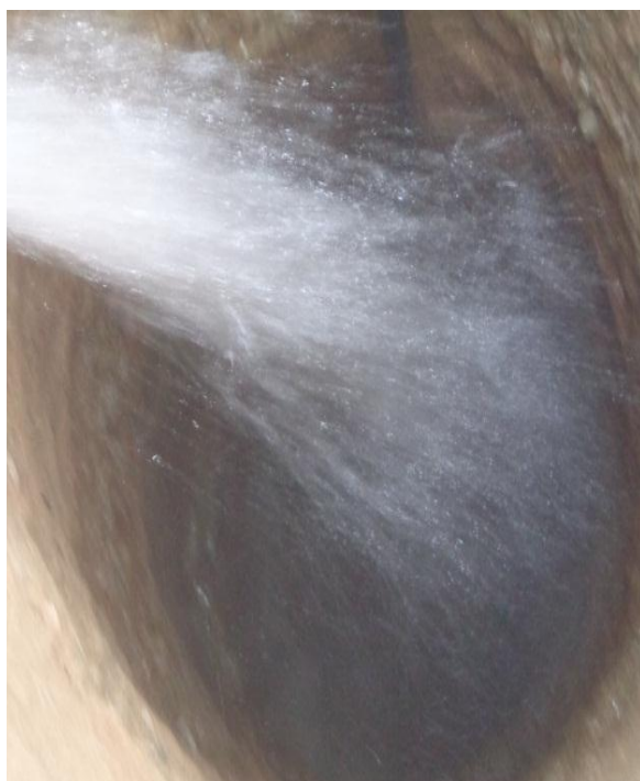
شکل ۳-۴) تزریق مستقیم آب به درون چاه با استفاده از تانکر
