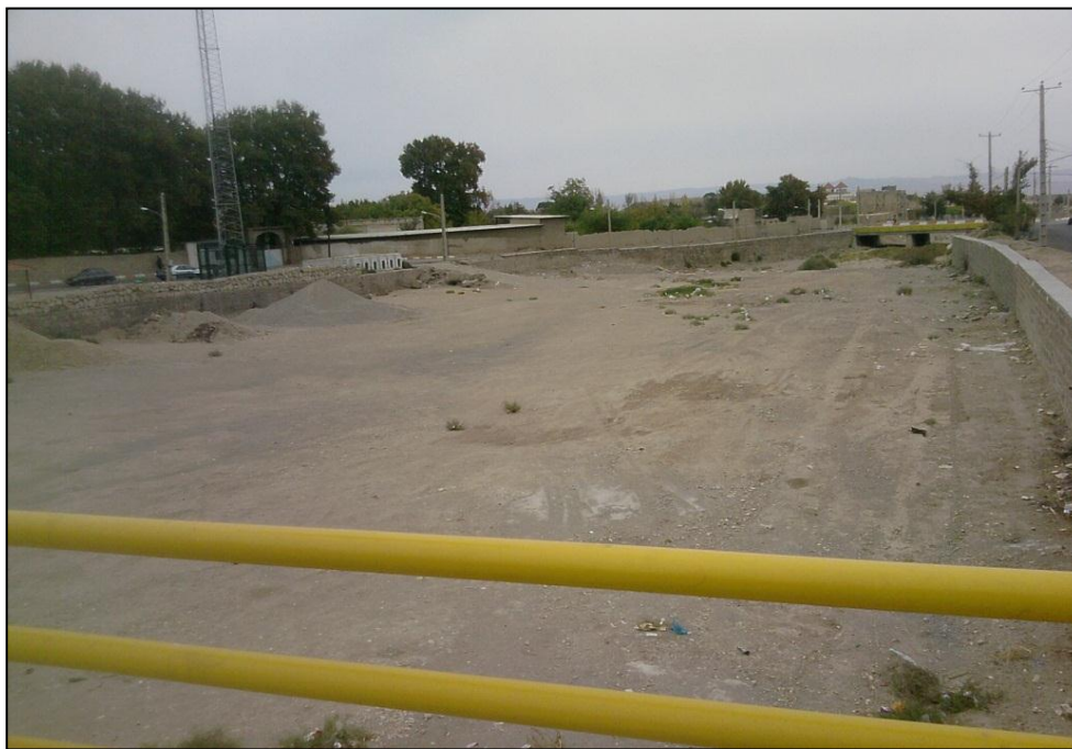
شکل ۱-۴- رودخانه خشک شاهرود (پل سرچشم)
