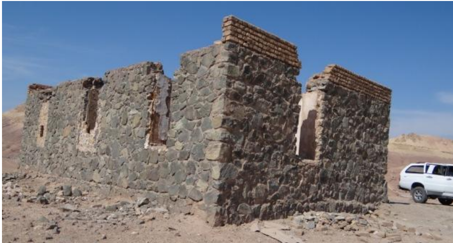
شکل ۱۸-۲: کاربرد سنگ‌های آذرین در ساختمان سازی اطراف معادن گرمسار.
