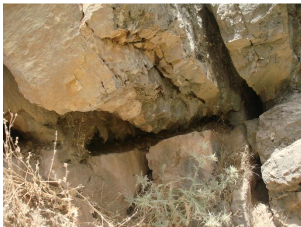
شکل ۴-۲۷- نمونه از درزه‌های در امتداد لایه‌بندی. به ابعاد و بازشدگی این دسته از درزه‌ها توجه شود. همچنین درزه با شیب کم جزء درزه‌های دسته ۲ بوده که شیب کم داشته و دارای اثرات انحلالی شدید در سطوح خود می‌باشد.
