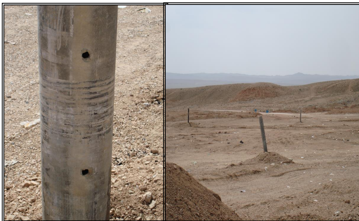
شکل (۲-۳) - نحوه قرار گیری لوله‌های جمع‌آوری گاز
