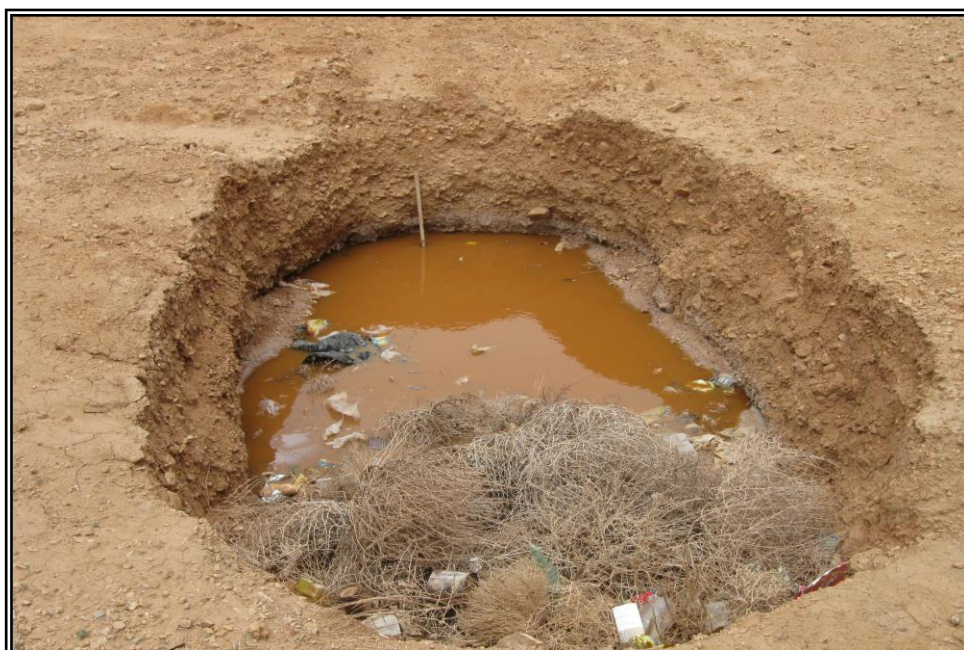
شکل (۴-۱۰) - نمایی از شیرابه خروجی در اثر فشرده شدن هنگام دفن
