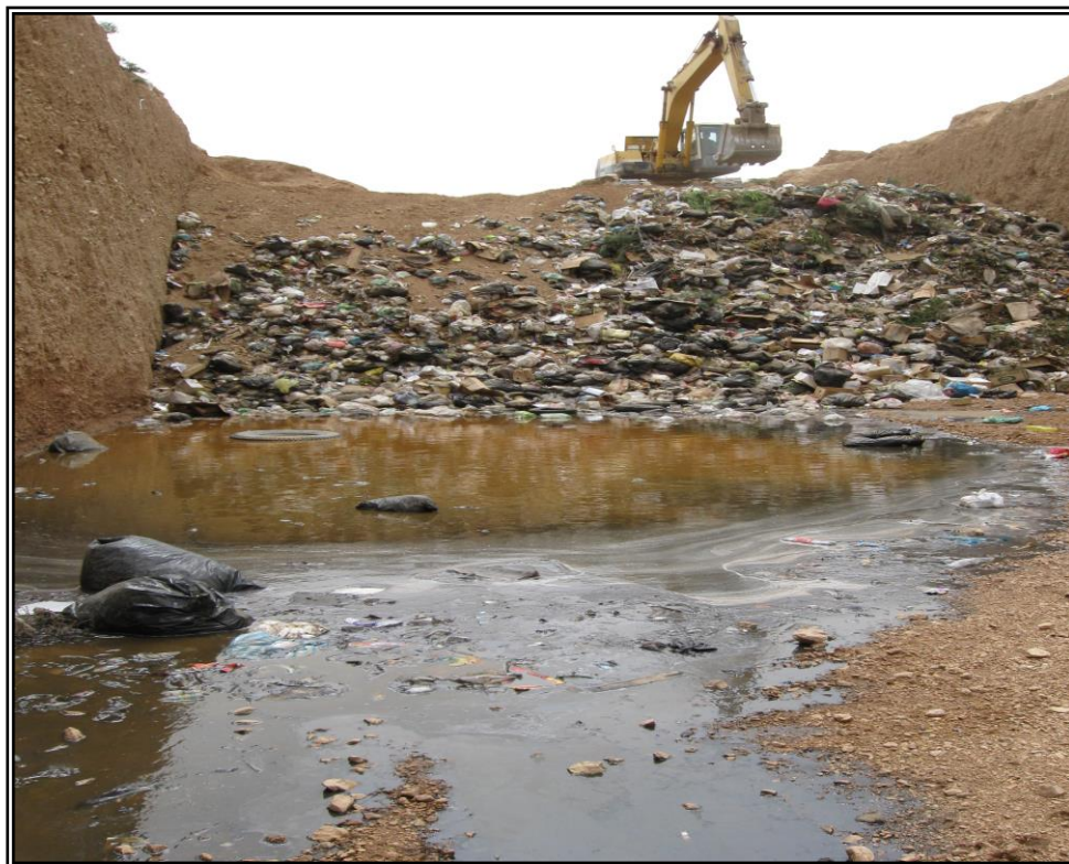
شکل (۴-۱۰) - نمایی از شیرابه خروجی در اثر فشرده شدن هنگام دفن
