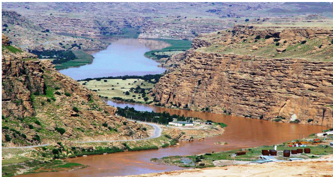
شکل ۲-۶: شکل دیواره‌ها در محل سد گتوند
