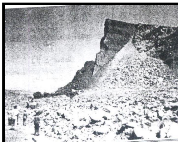
شکل ۱-۲- مقطع شکست سد زیرون از پایین دست
