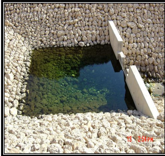
شکل 3-31- دبی سنج ( V-notch )
