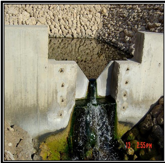
شکل 3-31- دبی سنج ( V-notch )
