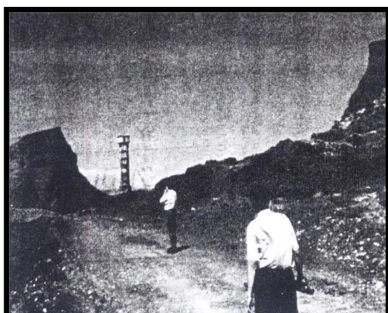
شکل ۱-۲- مقطع شکست سد زیرون از پایین دست
