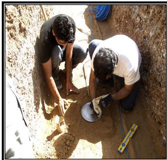
شکل 3-24- فشار سنج کل از نوع تار مرتعش
