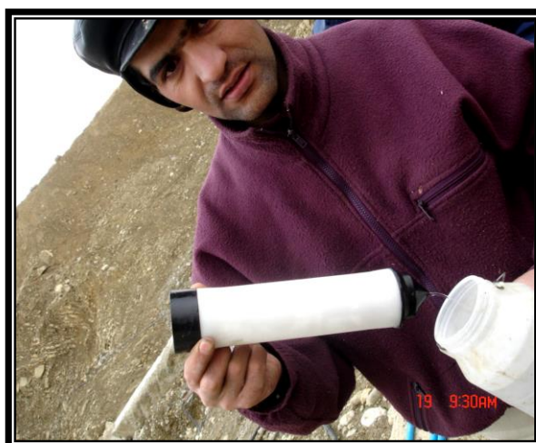
شکل 3-9- اتصال فیلتر به لوله کاساگرانده
