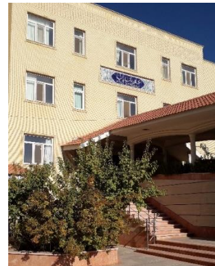
شکل ۵-۶ ورودی ساختمان اقامتی بانوان
