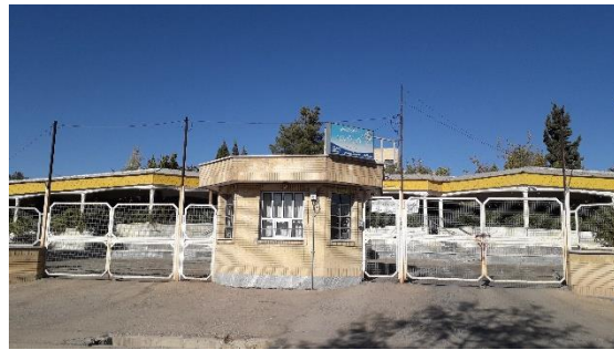
شکل ۴-۱۳ نگهبانی ورودی آسایشگاه
