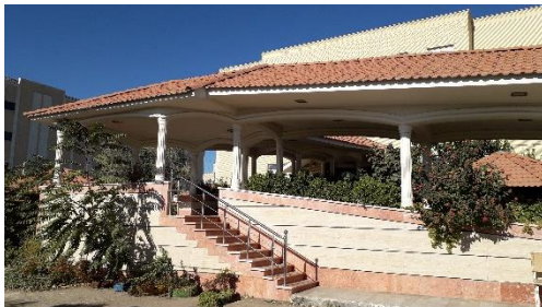
شکل ۱۳-۲ ورودی ساختمان اقامتی بانوان
