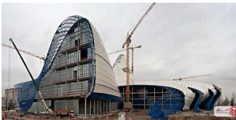
تصویر ۳-۲۵. سازه مرکز فرهنگی حیدر علی اف (منبع: www.disamag.com )
