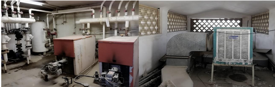
تصویر ۳-۱۱. تاسیسات گرمایشی و سرمایشی اداره گاز شاهرود (منبع: نگارنده)
