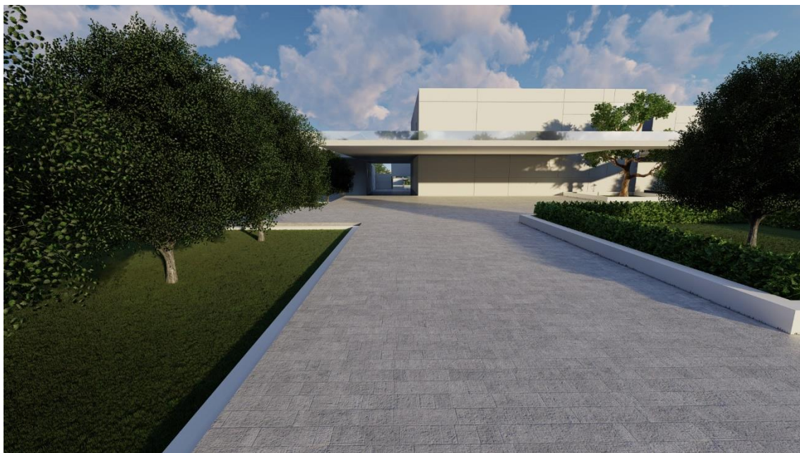
تصویر ۴-۳۷. دید ناظر به ورودی بنا از ناحیه شرقی (ورودی درجه دوم) مجموعه. ماخذ: نگارنده
