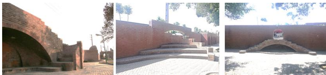
تصویر ۳-۴۸. بخشی از دیواره ضلع جنوبی. مأخذ: آرشیو مهندسین مشاور پل میر
