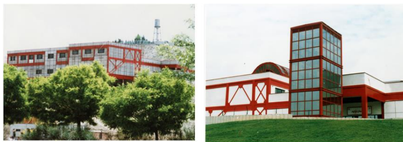
تصویر ۳-۳۸. نمای شمالی ساختمان پژوهش و پالایش پلاسما. مأخذ: آرشیو مهندسین مشاور پل میر
