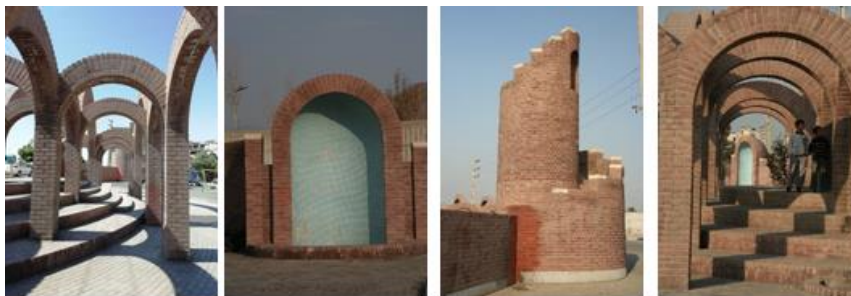
تصویر ۳-۴۷. بخشی از دیواره ضلع جنوبی. مأخذ: آرشیو مهندسین مشاور پل میر
