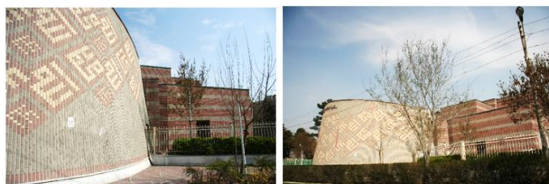
تصویر ۳-۵۵. نمای خارجی از آمفی‌تئاتر کتابخانه دولت‌آباد. مأخذ: آرشیو مهندسین مشاور پل میر
