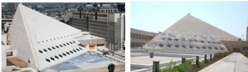
تصویر ۳-۲۶. نمای خارجی. مأخذ: آرشیو مهندسی مشاور پل میر
