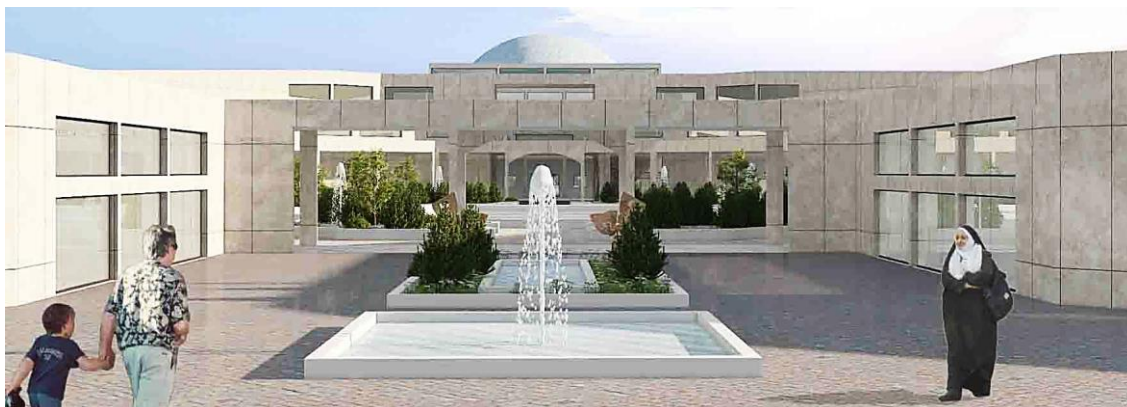
شکل ۶-۲۲. حوض، آب‌نما و فضای سبز به‌کاررفته در قسمت‌های روباز سایت
