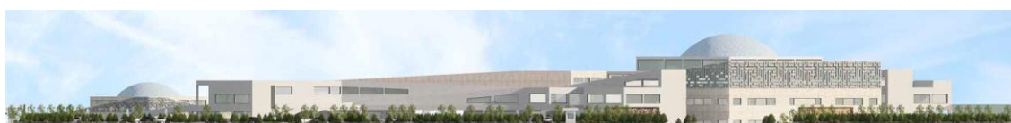
شکل ۷-۱۰. نمای جنوبی مجموعه
