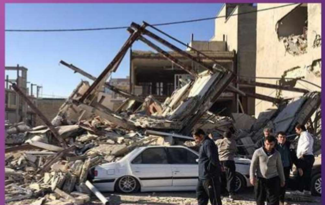
فروریزش سازه فولادی دارای دو سیستم متفاوت مقاوم لرزه‌ای در دو جهت (قاب خمشی و مهاربندی)
