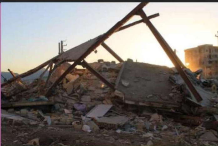
فروریزش سازه فولادی دارای دو سیستم متفاوت مقاوم لرزه‌ای در دو جهت (قاب خمشی و مهاربندی)
