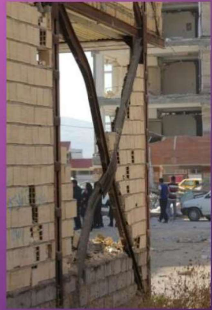
کمانش عضو بادبندی لاغر در فشار حول محور ضعیف ( تک پروفیل IPE )
