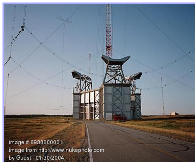
شکل (۲-۱۰) ایستگاه فرستنده GBR [۴۰]
