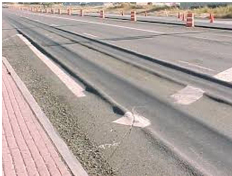
شکل ۱-۲ شیار شدگی با شدت زیاد (www.pavementinteractive.org)
