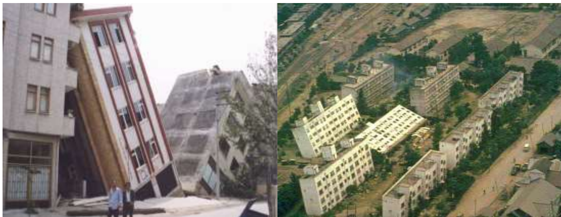
شکل ۲-۶ کج شدن آپارتمان‌های کاواگیشیچو در زلزله‌ی نیگاتا (سمت چپ) و شکست پی در زلزله‌ی آداپازاری (سمت
